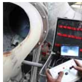
Roboterkameras helfen Einblicke in Anlagenteile zu bekommen, die sonst nicht einsehbar wären
