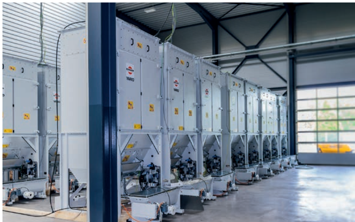
In einer extra dafür angemieteten Halle nahmen Volvo CE und Keller die Absauganlage vor Auslieferung testweise in Betrieb
